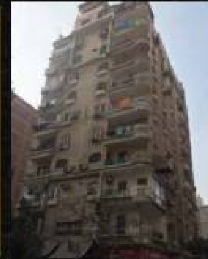
برج المهندسين 3 حلوان Engineers Tower 3 Helwan
