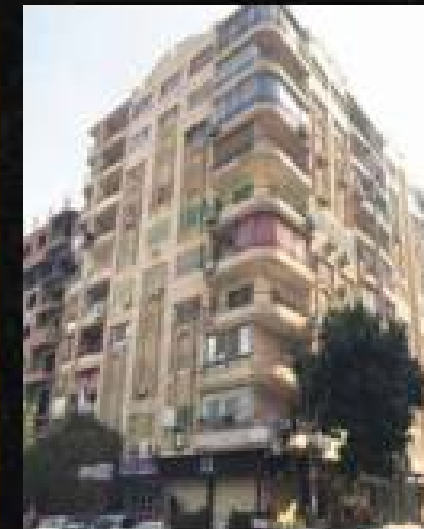
برج عزام - حلوان Azzam Tower Helwan
